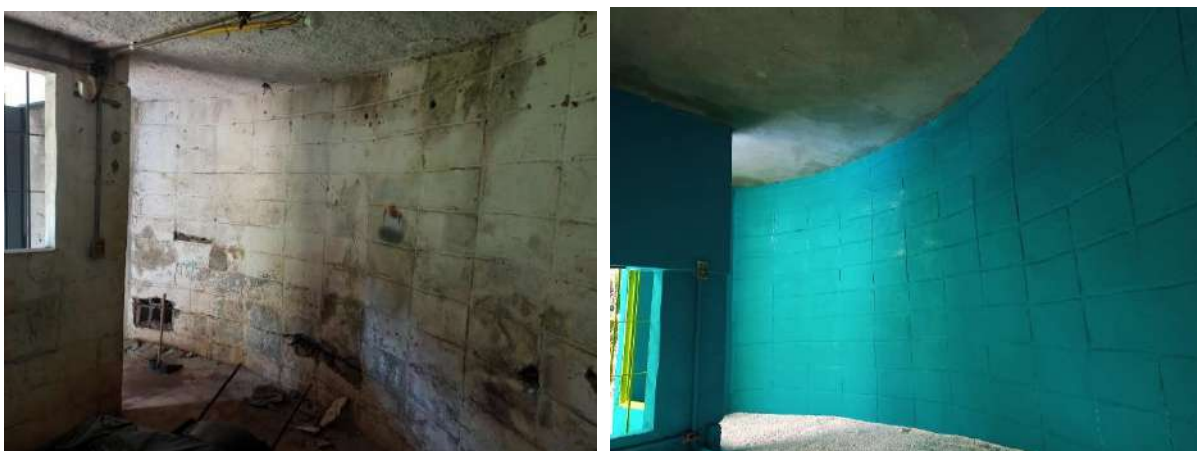
Figura 21: Casa do lago (antes e depois)
