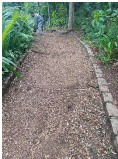
Figura 9: Distribuição do material triturado para proteção do solo
