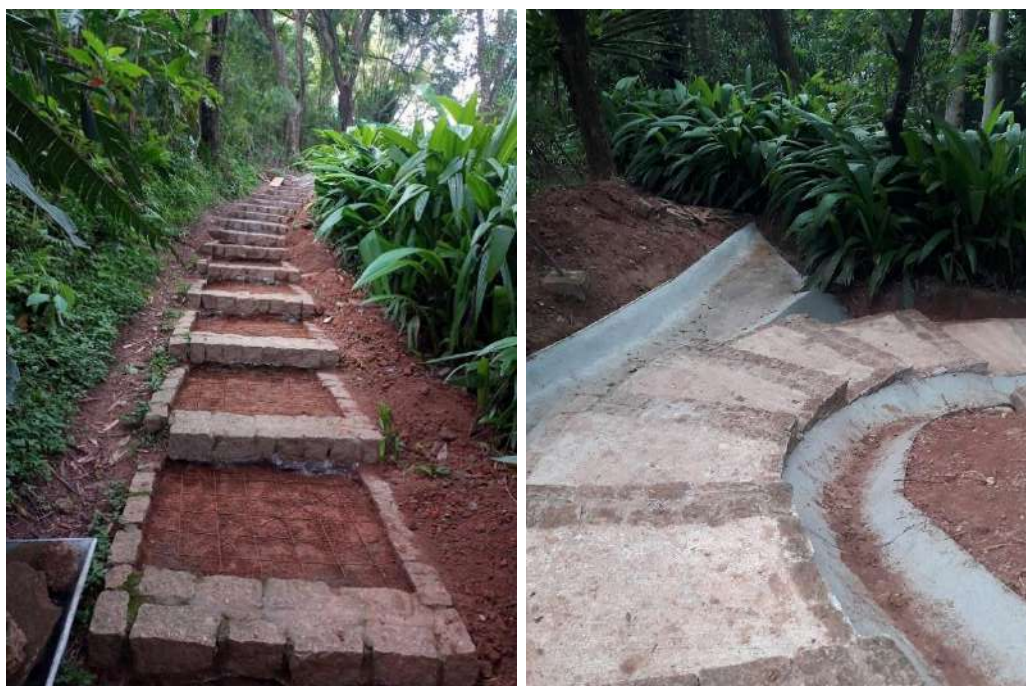
Figura 17: Adequação dos acessos
