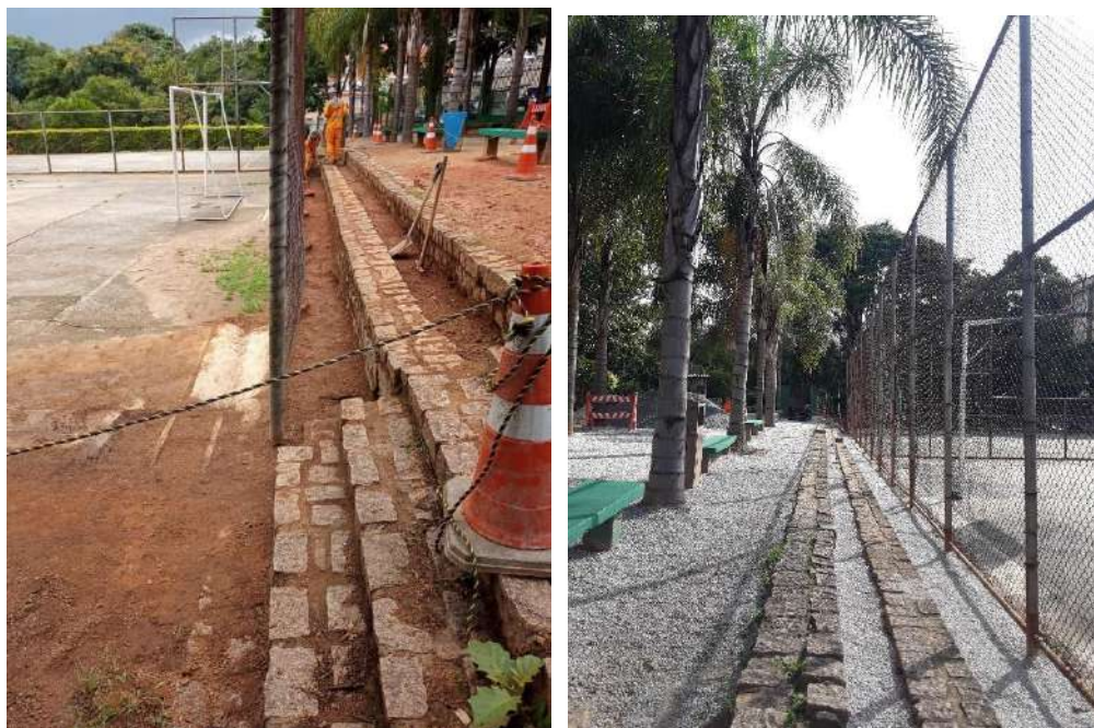
Figura 20: Melhorias na arquibancada
