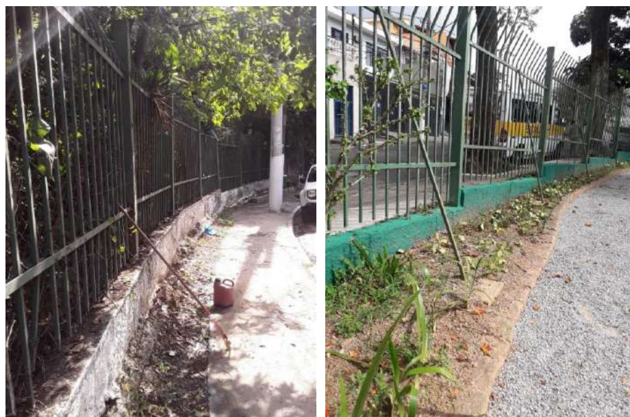
Figura 24: manutenção do gradil (antes e depois)
