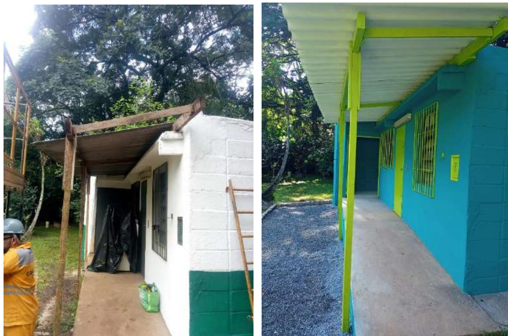
Figura 22: Casa do lago (antes e depois)
