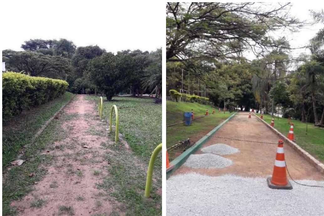
Figura 18: Adequação dos acessos (antes e depois)
