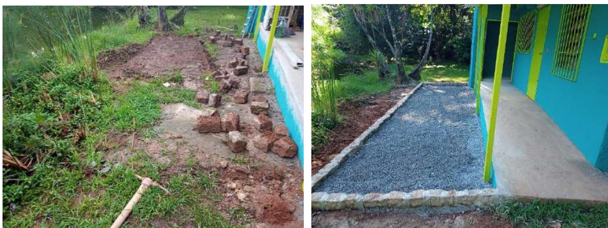
Figura 23: Casa do lago (antes e depois)
