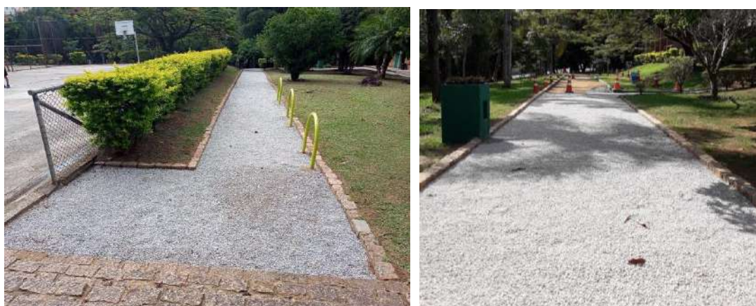
Figura 19: Adequação dos acessos
